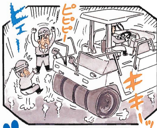
重機、後方での異常接近
